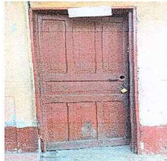
Foto 6: Modulo 6: Puerta de cocina dañada y apollada.
